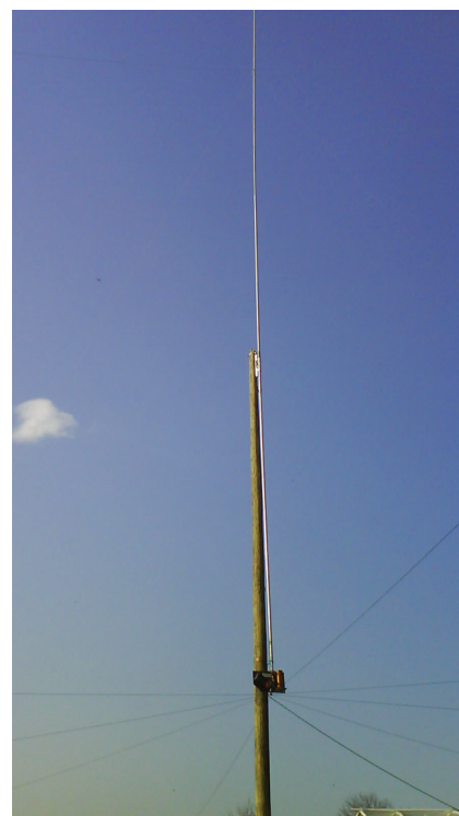
Slika 4. Izvedena konstrukcija EVA-DX 40/80
